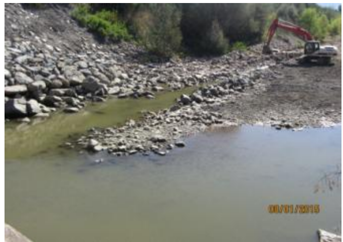
Drenaje de poza en el sector Tunel Sur
